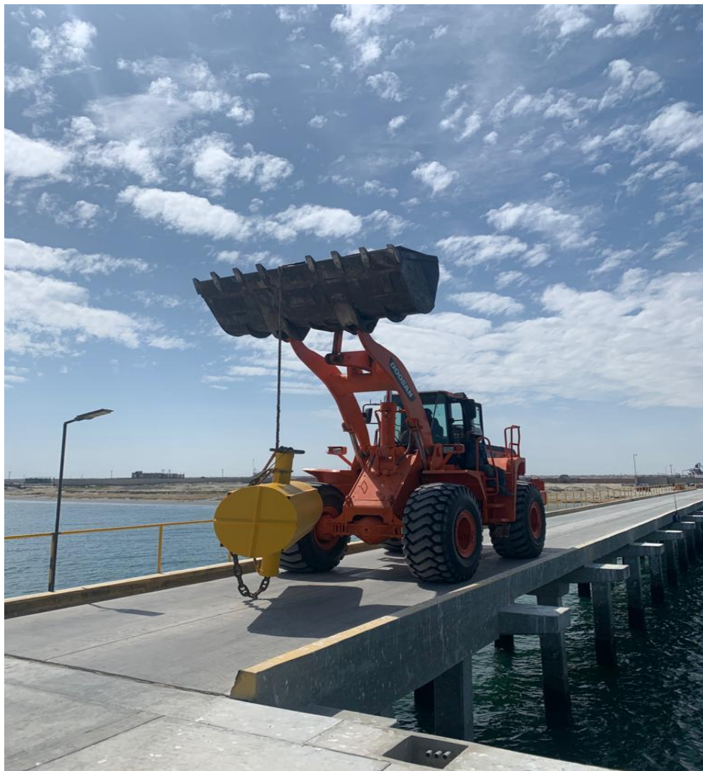
Instalación y mantenimiento de boyas
